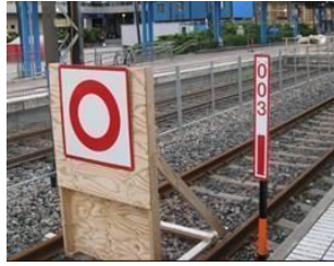
Kuva 3 SEIS-levy. Tätä merkkiä käytettävä aina, kun rata suljetaan liikenteeltä ratatyön ajaksi.
